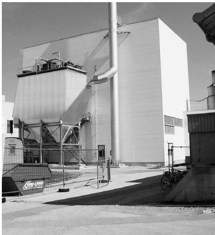
Energie aus Kaffeesatz: Verbrennungsanlage in Orbe.
