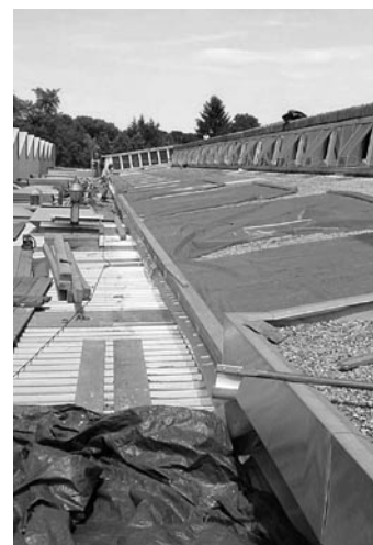
Bausanierung bei der Lista AG: Die Dachisolation, die neuen Oberlichter und eine neue Hallenbeleuchtung führen zu Einsparungen von thermischer und elektrischer Energie.
