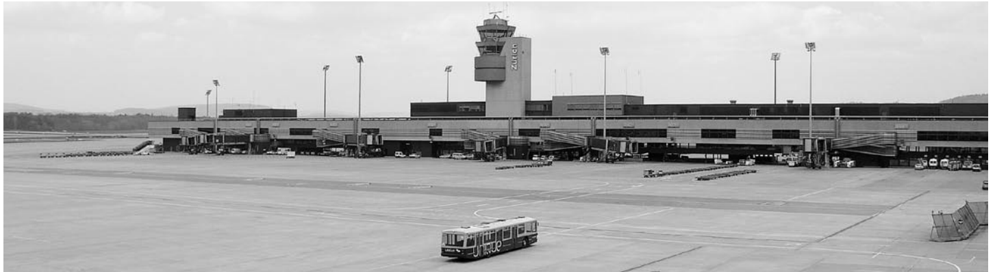
Des infrastructures performantes sont indispensables.
