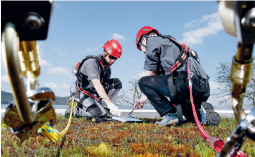
Des mousquetons, des cordes et des sangles de sécurité pour protéger les travailleurs contre une chute dans le vide.
